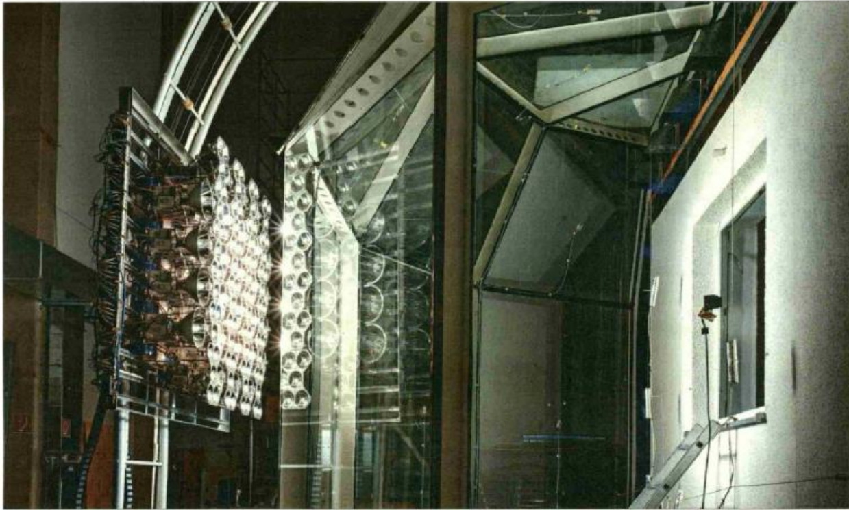
Fluidglas ist die erste Glaskonstruktion mit dynamischem Energiespeicher.
